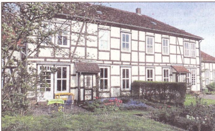
Umfassend saniert: Die Alte Schule in Rosenthal.
